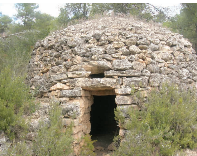
Barracoza. Construcción de piedra en seco
